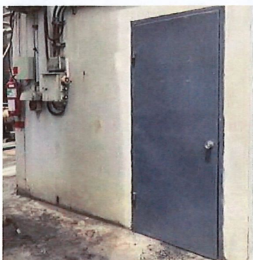
ภาพที่ 3 ผนังควบคุมเสียงจากเครื่องกำเนิดเสียง
