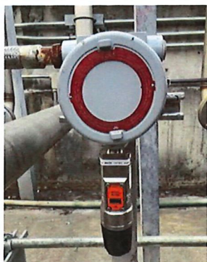
ภาพที่ 1 Gas detector ที่บริเวณถังเก็บสารเมทานอล
